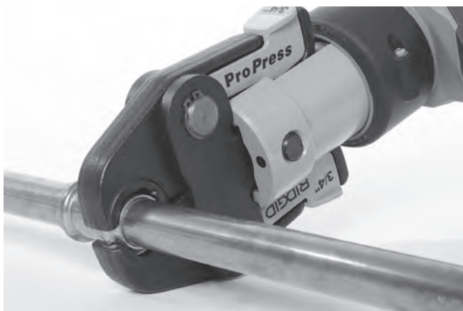
Figuur 9 – Aanbrengen van schaarbekken rond fitting
